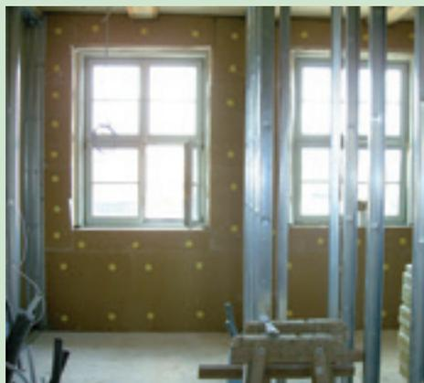
bereits montierte **UdiIN®** Holzfaserdämmplatten
