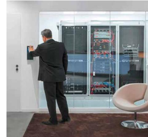
Die intelligente Steuerung der Zutrittsleser erfolgt über die INTUS ACM Zutrittskontrollmanager. Diese werden vom zentralen Leitrechner mit Stammdaten versorgt und entscheiden über Sperre oder Öffnung von Türen, Toren & Co.
