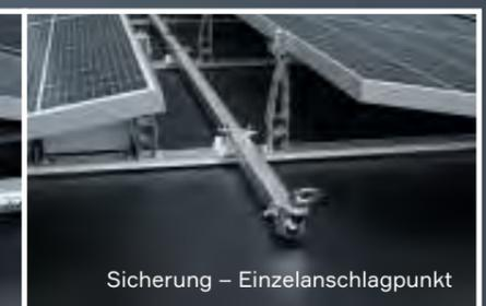
Sicherung – Einzelanschlagpunkt
