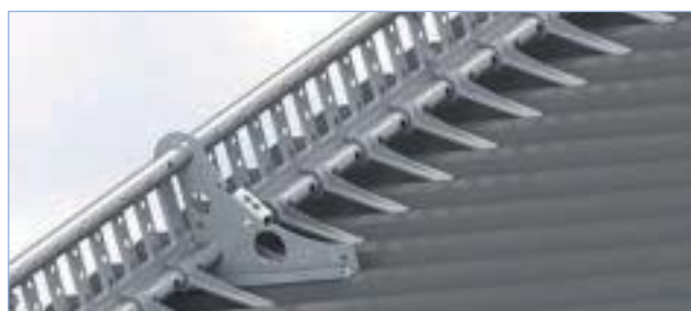
Konsole Falzhalterung
